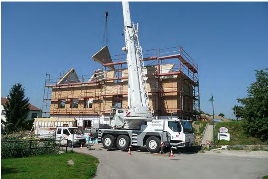
Abbildung 55: Haus Piller, Vorfertigung mit Strohdämmung, Passivhausstandard (Quelle: Fa. Holzbau Unfried)
